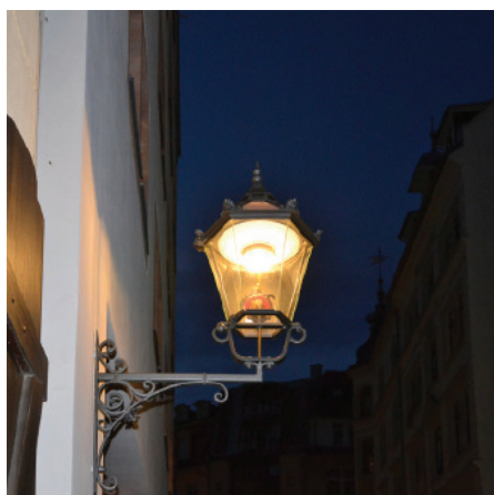
360 réverbères de type Schinkel s’illuminent la nuit grâce à la technologie LED moderne
